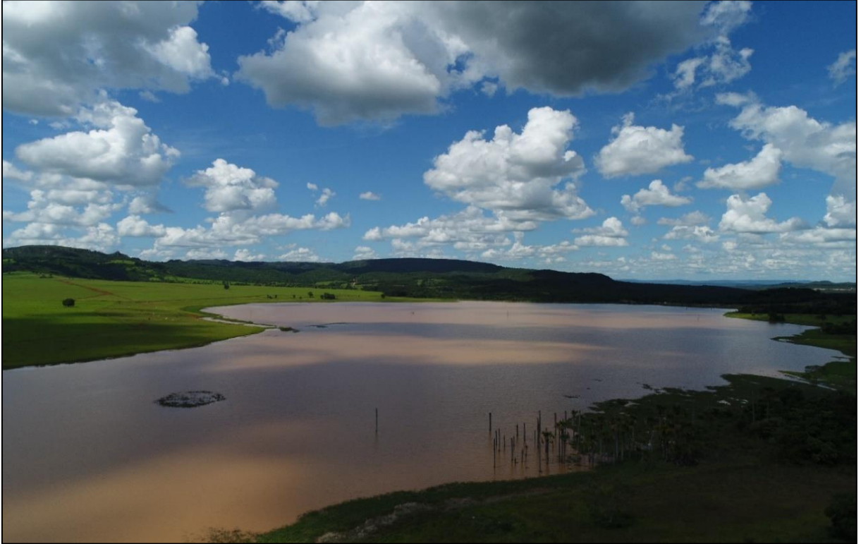
Foto 2. Barramento da PCH Tamboril, no período chuvoso
